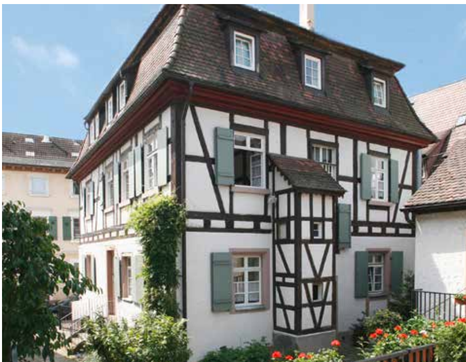
2016 wird von einem Bauträger ein Neubau für das Integrationszentrum in Lahr errichtet. Die Adaption Lahr ist ein Einrichtungsteil der Rehaklinik Freiolsheim. Sie bietet sieben Plätze im Betreuten Wohnen nach stationärer Suchtbehandlung.
