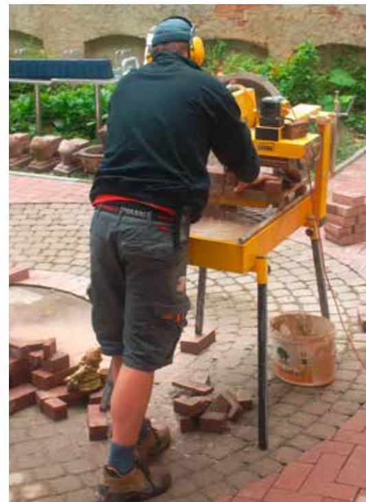
Aufgabe des Gebäudemanagements ist, die Gebäude und Anlagen funktionsfähig zu halten. Hierzu werden Umbauten, Sanierungen, Modernisierungen und Mängelanalysen durchgeführt sowie ein Informationsmanagement eingesetzt.
