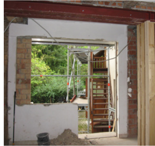
Die aufwändige Gebäudesanierung bei der Wohnungslosenhilfeeinrichtung „Haus Eliah“ und die Sanierungsarbeiten an der Fassade des Integrationszentrums Lahr, die 2014 abgeschlossen wurden, zeigten die Leistungsfähigkeit der Zweigstelle Offenburg und deren Mitarbeiter.
